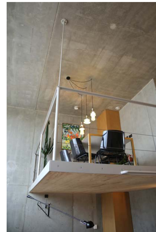
[13] Råhus med monteret etagedæk. Amsterdam
