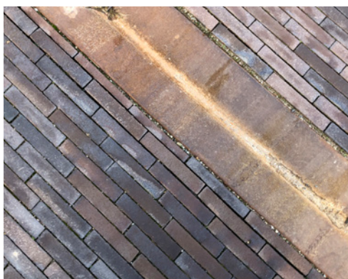
Fig.16. Detaljfoto af vejbelægning og materialer på Sydmose Allé, der er anlagt med teglklinker, grus, cortenstål. På øvrige nyanlagte boligveje i Skousbo anvendes også asfalt. Alt sammen materialer, der må anvendes i etableringen af denne lokalplans boligveje. © Roskilde Kommune
