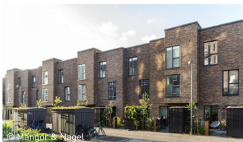
Fig.25. Øverst: Billedet viser sammenhængende byhuse i ensartede materialer, hvor den enkelte bolig markeres af detaljer i murværket og tagprofilen ved hvert lejlighedsskel. Nederst: Billedet viser en sammenhængende rækkehusbebyggelse, hvor forskydninger i facaden, karnapper samt markering af indgangspartier skaber en variation og markering af hver bolig. Begge billeder er eksempler på en facadevariation, som lokalplanen stiller krav om.
