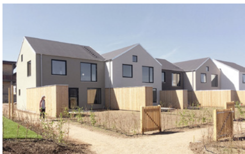
Fig.19. Billedet viser et eksempel på, hvordan en facadelinje kan opbrydes med forskydninger i facaden og rotation i tagryggen. ©hyrdehoj.dk
