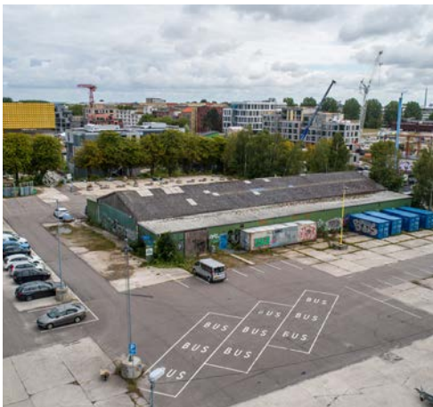
Fig.5. Hal 11 bevares som en åben søjlekonstruktion og vil få funktion af et åbent byrum og mødested for Hal 12-kvarterets beboere og brugere. Hall 11 placerer sig mellem lokalplanens to delområder.
