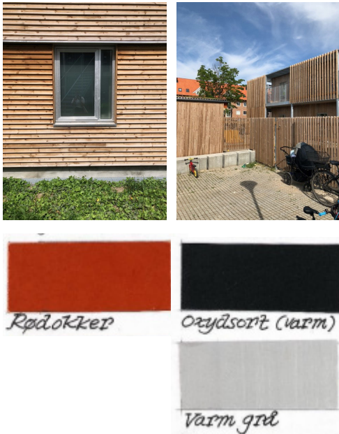
Fig.22. Fotos af bygninger med facadebeklædning af træ - Skousbo (tv) og børnehuset Bikuben (th) samt farveangivelse til ældreboligerne © Roskilde Kommune
