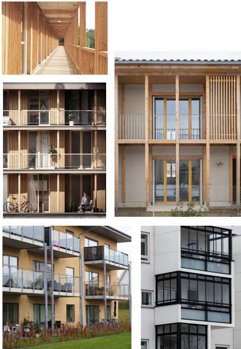
Fig.21. Øverst: Fotos af altaner, karnapper, søjler og svalegange, der er integreret i bebyggelsens arkitektur og som lokalplanen muliggør. Nederst: Fotos af altan på søjler og karnapper, der ikke er integreret i bebyggelsens arkitektur og som lokalplanen ikke tillader.
