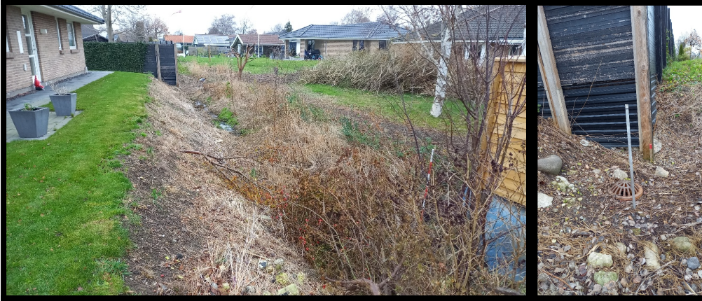
Figur 2. På fotoet til venstre ses det aktuelle åbne forløb af skelgrøften på strækningen set i nordlig retning. Det ses, at terrænet langs skelgrøftens nuværende åbne tværprofil er væsentligt lavere på matriklerne øst for skelgrøften (Svanevænget 13 og 15). På fotoet til højre ses eksisterende indløbsbrønd med topist med afløb til eksisterende rørlægning af skelgrøften.
