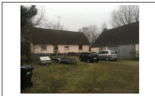
Foto 2: Bolig (tv) og garagebygning (th).
