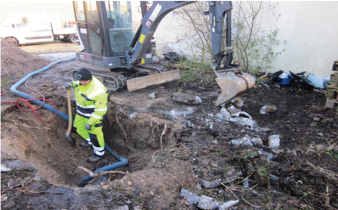
Udgravning med akut afværge i form af opsugning af flydende affald fra tromle/hul.
