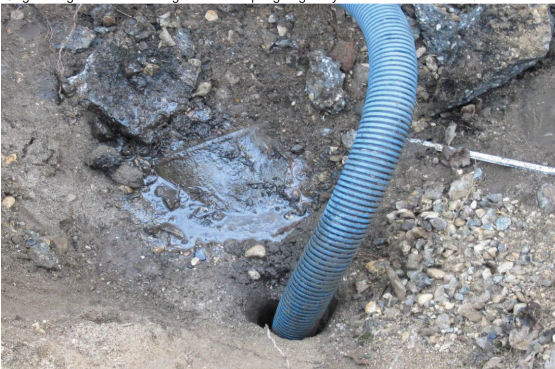
Opsugning af flydende affald fra boringshul i tromle
